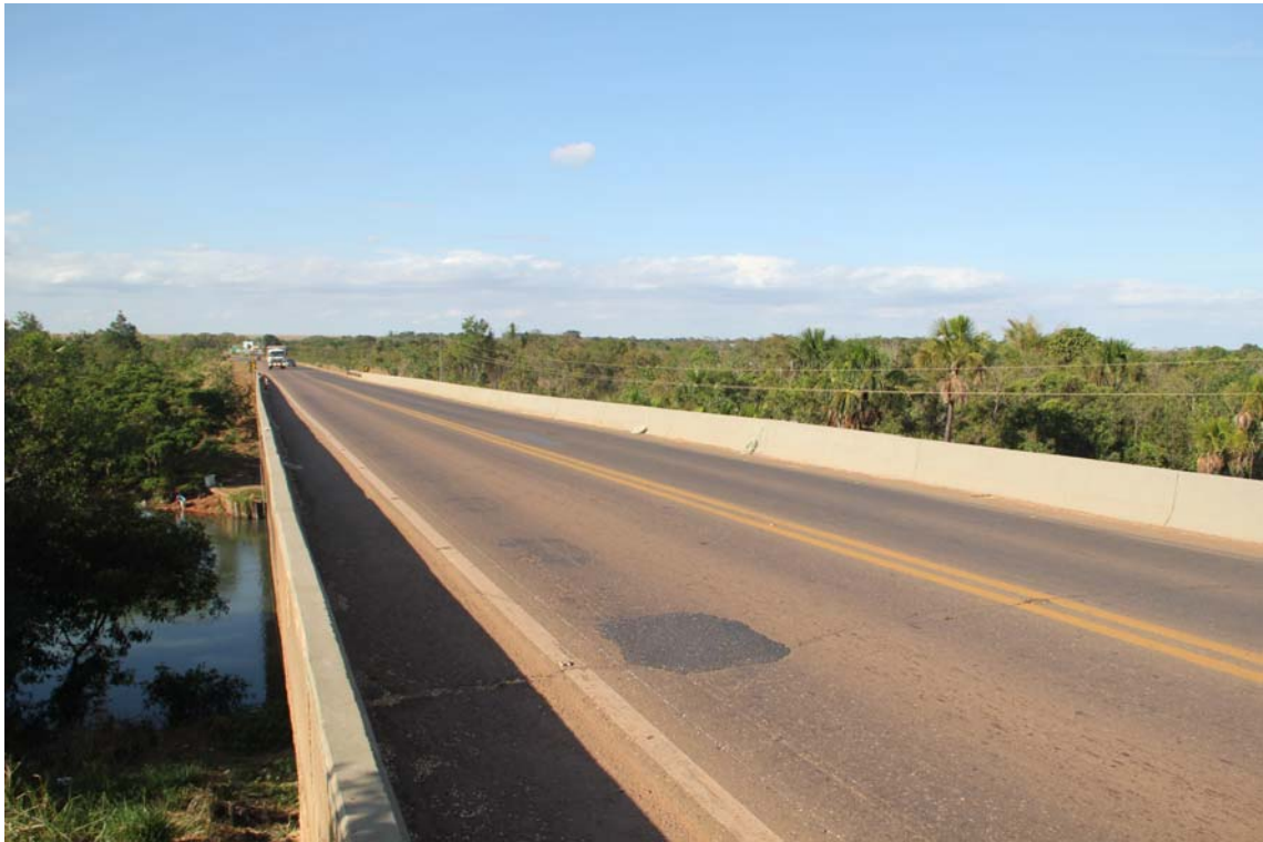
Foto 5 – Vista Superior da Ponte sobre o Rio Verde
