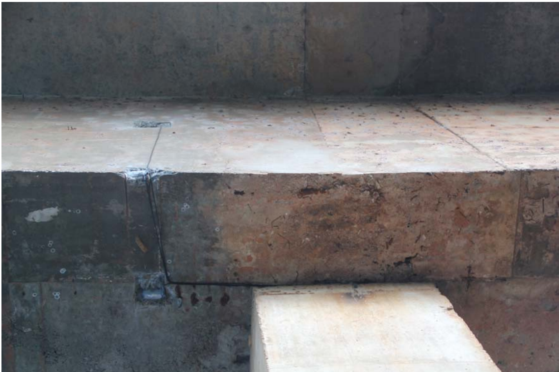
Foto 4 – Sensores “strain gages” instalados na face do apoio
