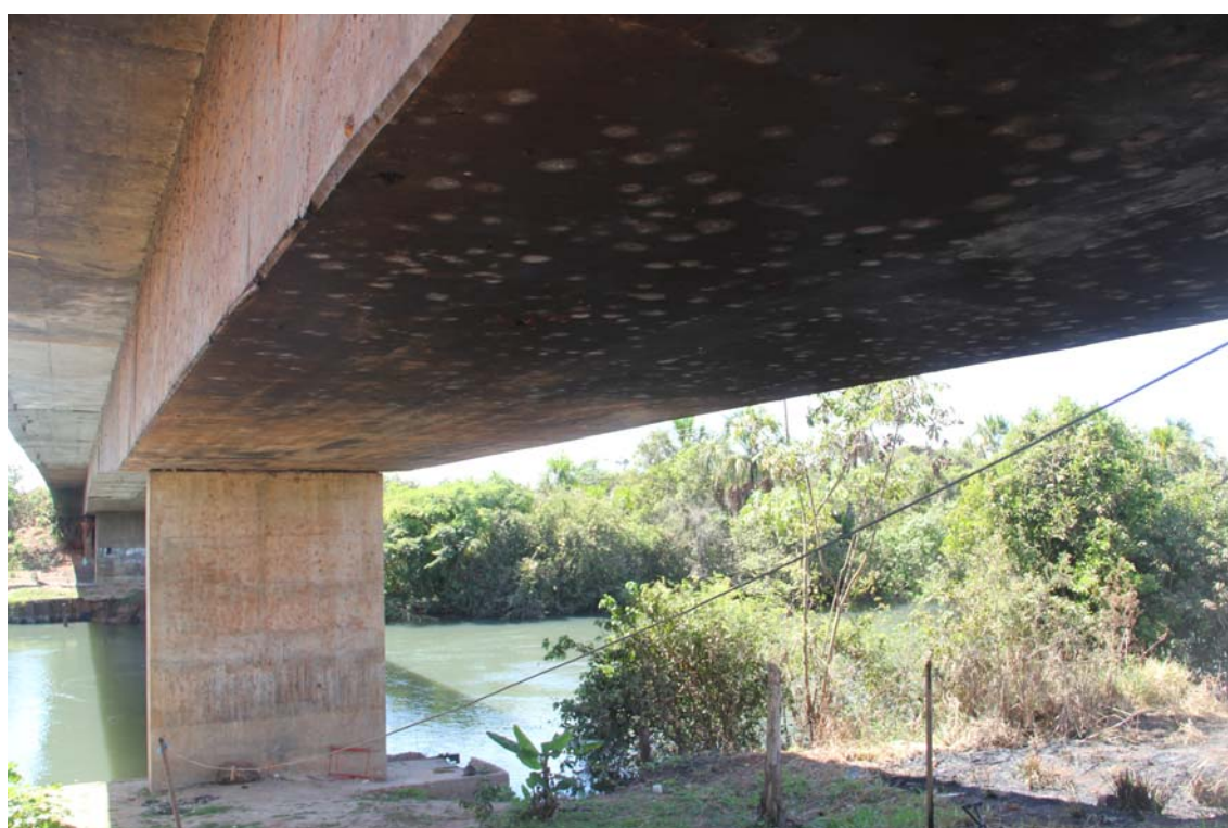
Foto 2 – Vista do pilar-parede e do primeiro vão
