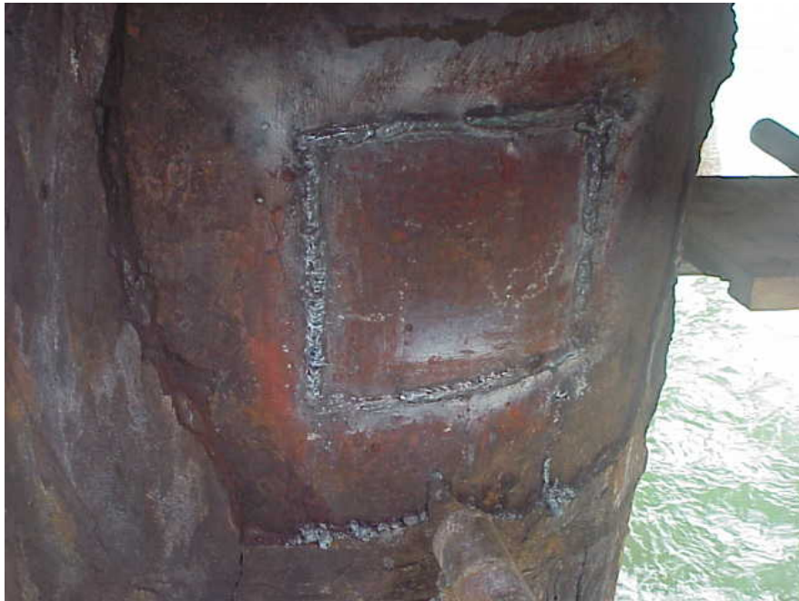
Foto 17 - Após inspeção as chapas foram soldadas nas estacas
