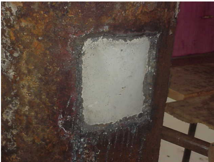
Foto 16 - Esta estaca localizada na extremidade voltada para o continente não apresentou anomalias no concreto
