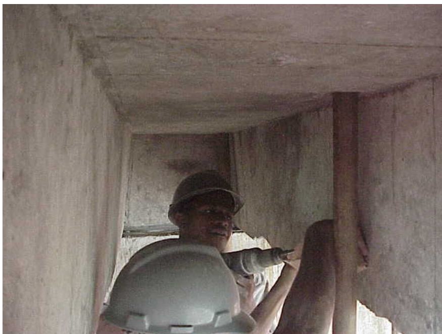
Foto 2 - Extração do concreto na forma de pó para a análise do teor de cloretos
