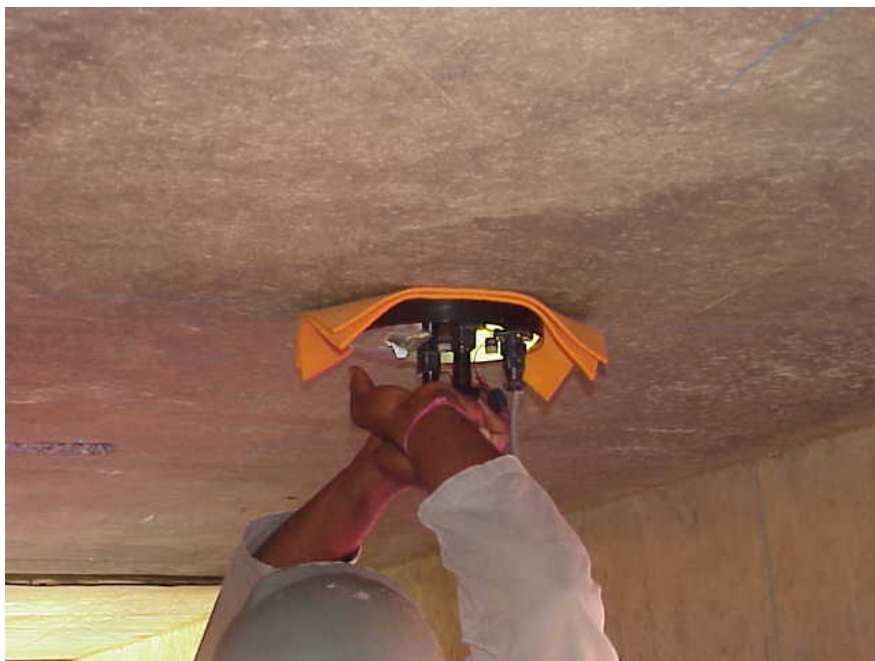
Foto 14 - Detalhe do disco de contato
