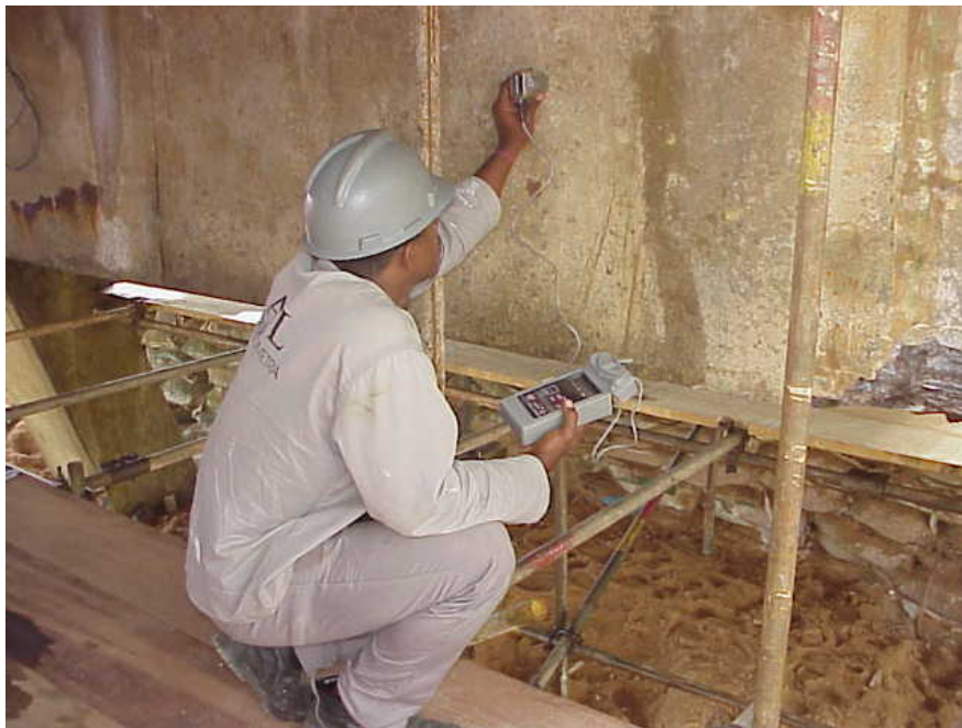
Foto 7 - Para localizarmos as armaduras utilizamos um pacômetro
