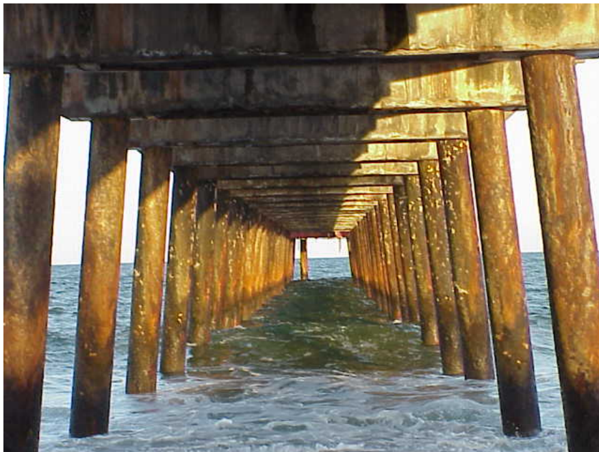
Foto 1 - Vista transversal do Píer do Emissário da Cetrel
