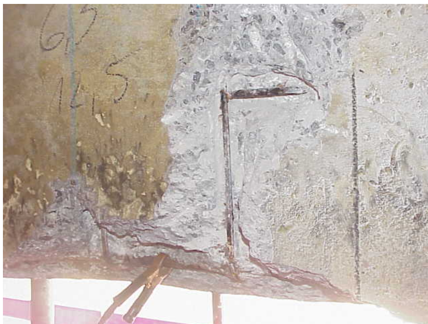
Foto 12 - Conexão entre armadura da viga e o equipamento GECOR 6
