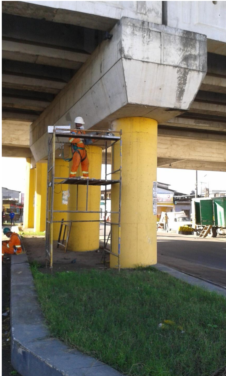
Foto 3 – Retirada da cobertura de concreto para instalar o sensor
