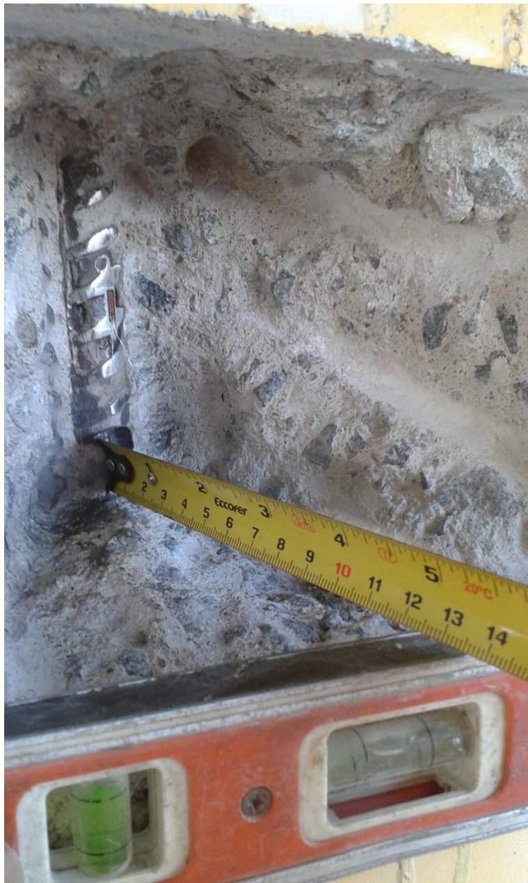
Foto 4 – Detalhe do sensor “strain gage” colado na armadura do pilar
