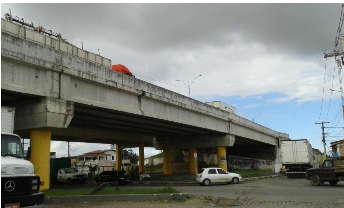
Foto 1 - Vista do Viaduto no Bairro Tomba
