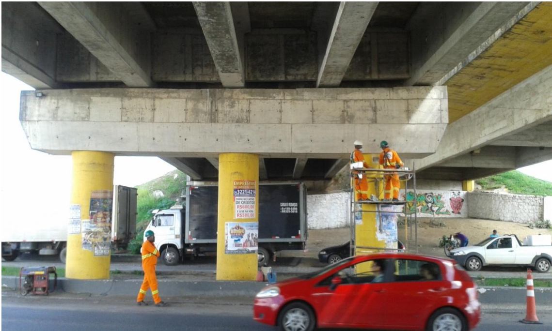
Foto 2 – Início da montagem e instalação dos sensores nos pilares
