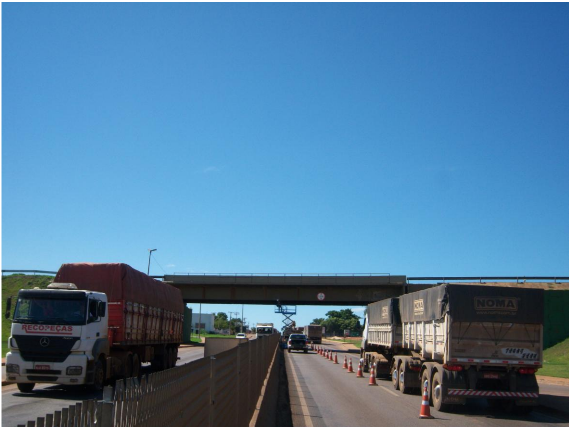
Foto 1 – Vista geral do Viaduto
