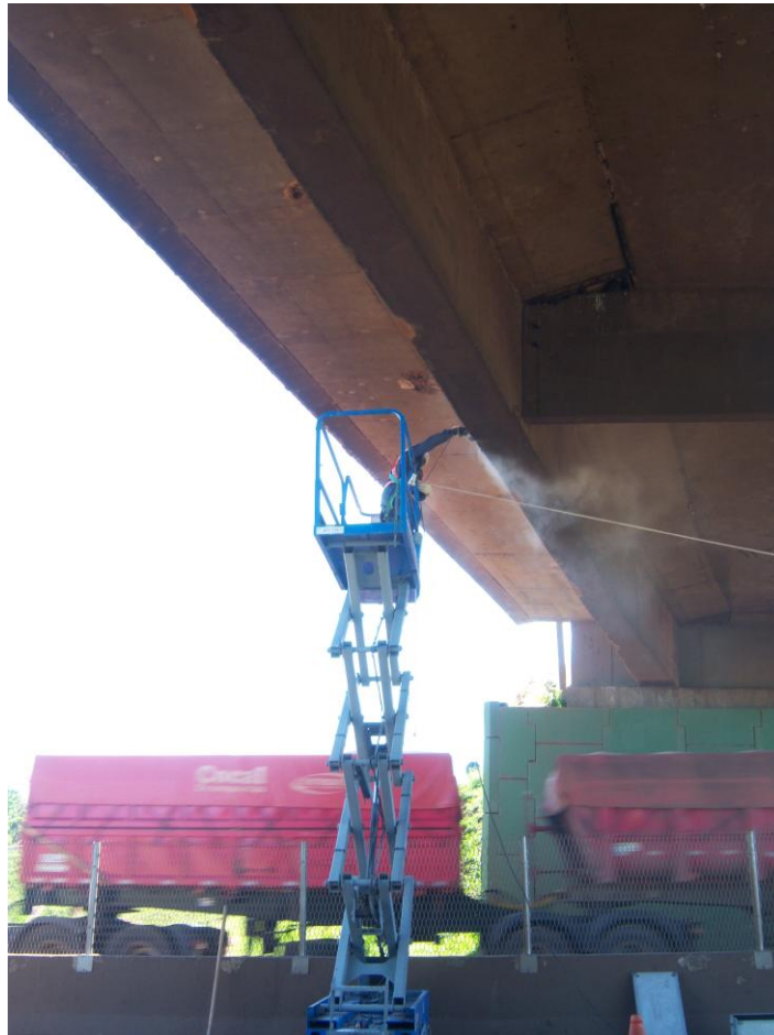
Foto 2 – Encarregado da AJL marcando a área (utilizando serra mármore) para expor a armadura, onde será instalado o sensor de deformação
