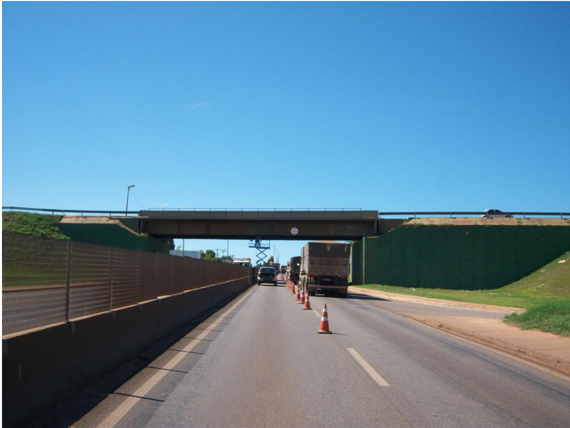
Foto 8 – Outra vista do Viaduto monitorado
