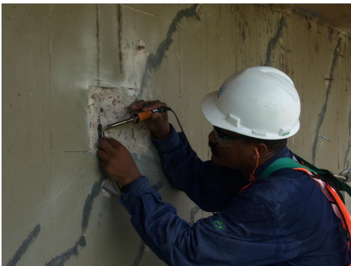
Foto 5 – Instalação finalizada com a solda do cabo aos filamentos do sensor
