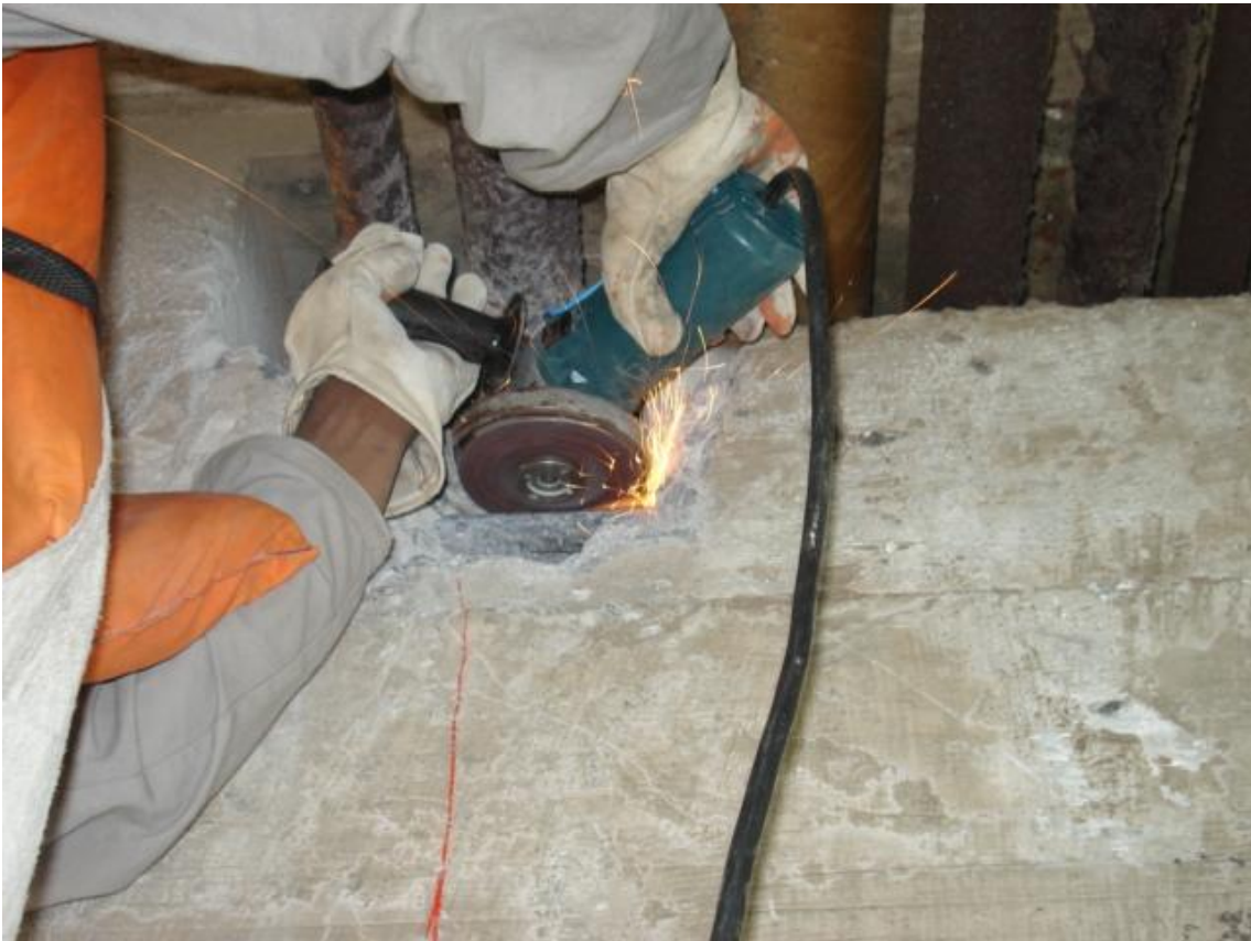
Foto 4 – Armadura sendo lixada com esmerilhadeira
