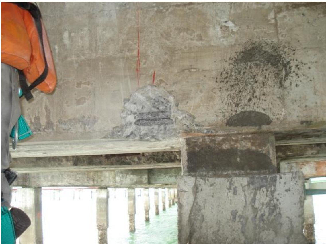
Foto 3 – Armadura exposta e pronta para ser lixada e limpa
