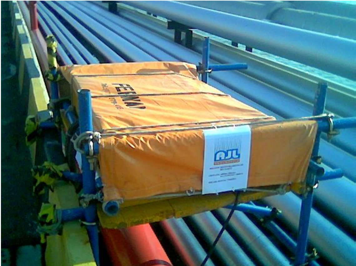
Foto 10 – Caixa devidamente protegida com o TAG da AJL no Píer do Parque Mirim
