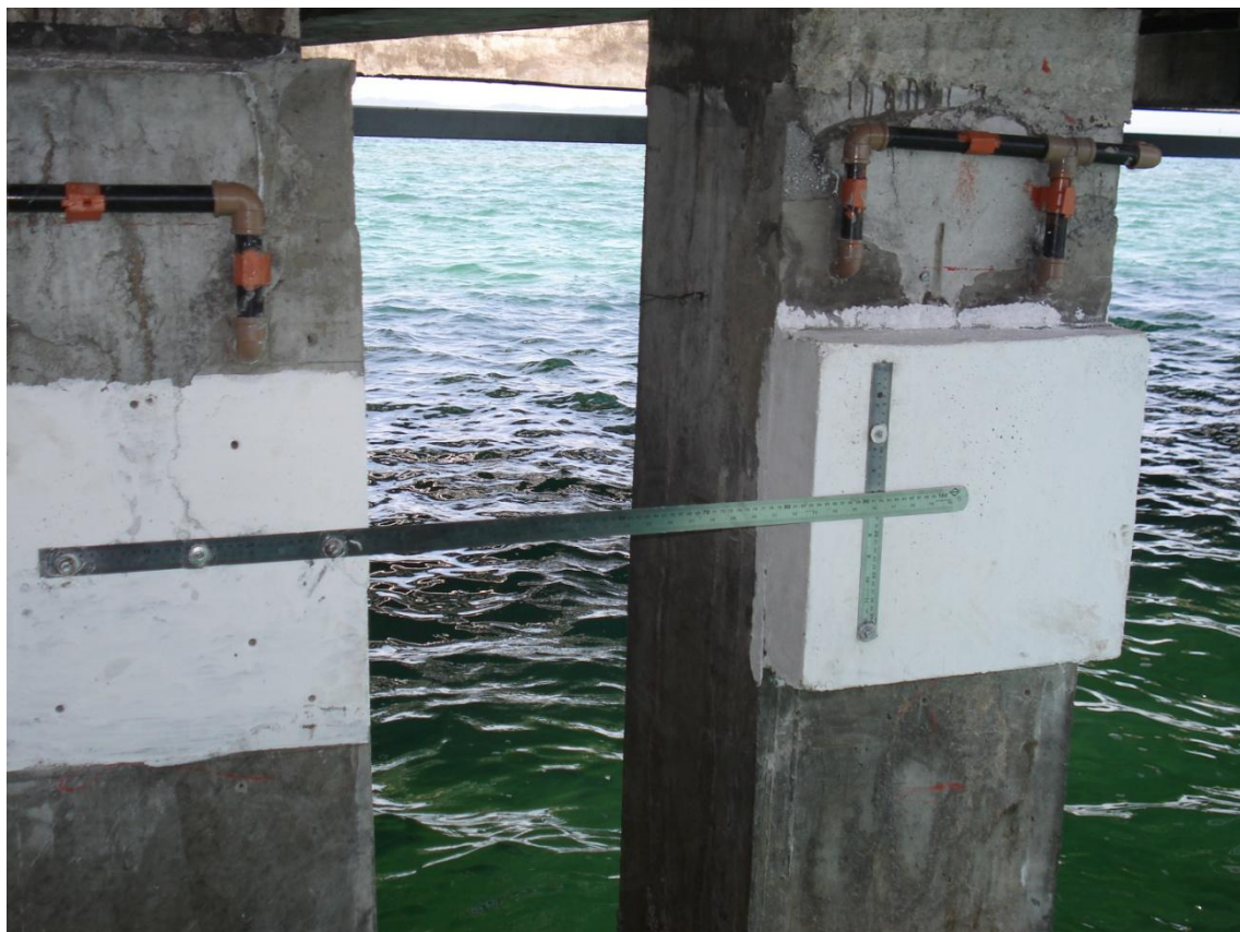
Foto 7 – Instalação de régua para verificar o recalque
