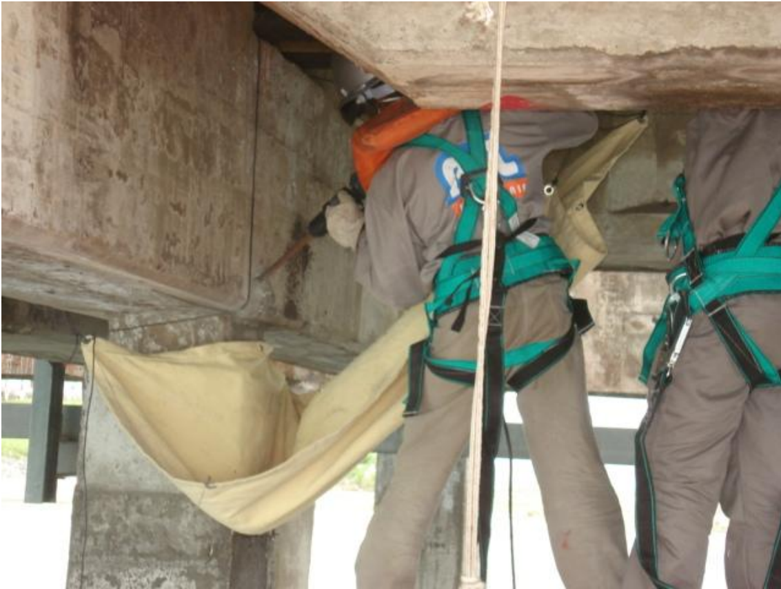
Foto 2 – Retirada do cobrimento da viga para instalação do sensor
