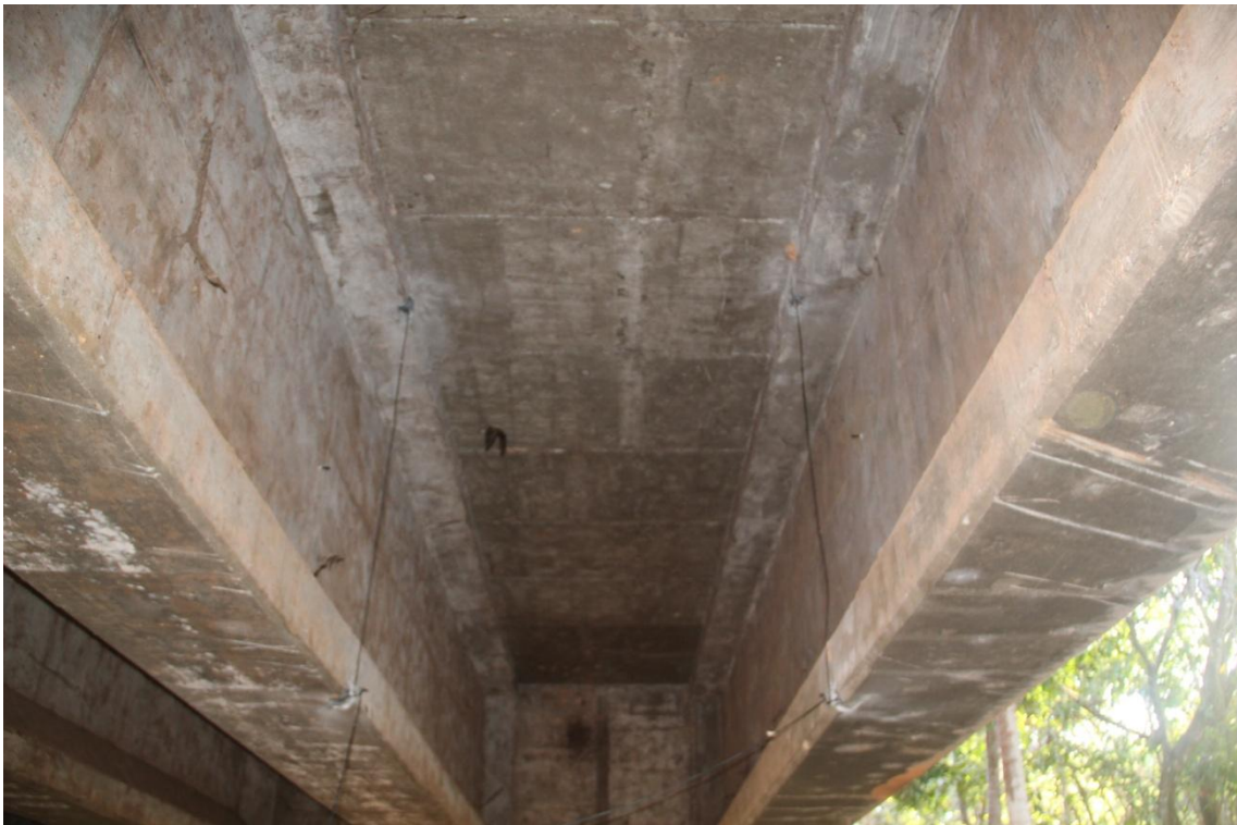
Foto 4 – Sensores de deformação “strain gages” instalados nas vigas, no meio vão
