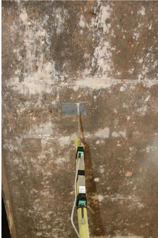
Foto 3 – Sensor de deslocamento “deflectômetro” instalado na laje para registrar a flecha no momento da passagem do conjunto
