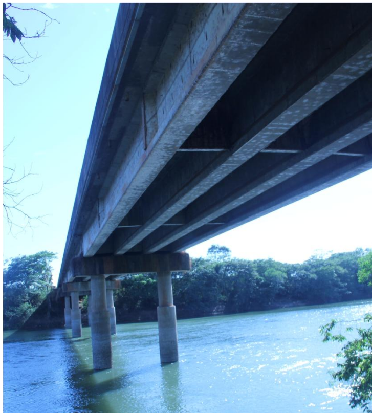
Foto 3 – Vista Geral da Ponte sobre o Rio Teles Pires
