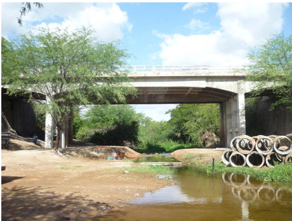
Foto 1 – Vista Geral da Ponte sobre o Rio Itapicuru Mirim já reforçada
