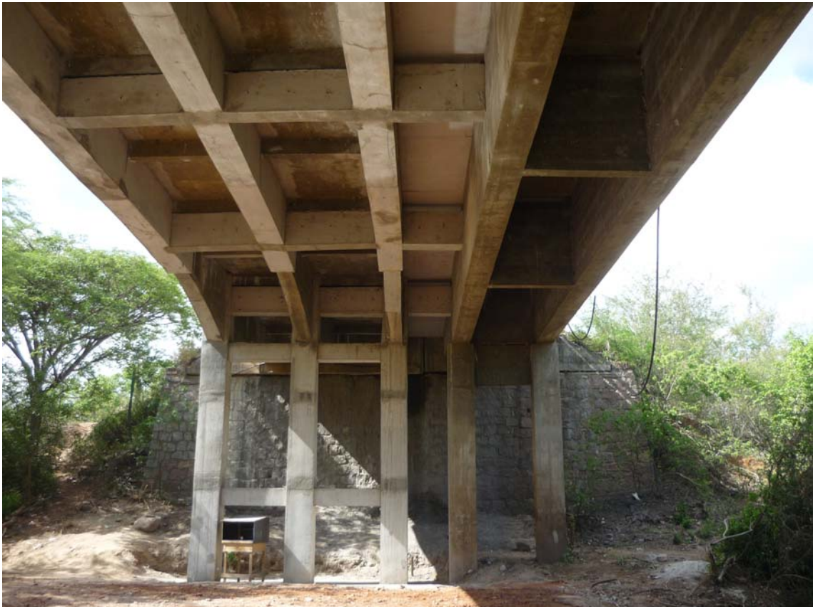
Foto 5 – Vista Vigas e Pilares Juazeiro
