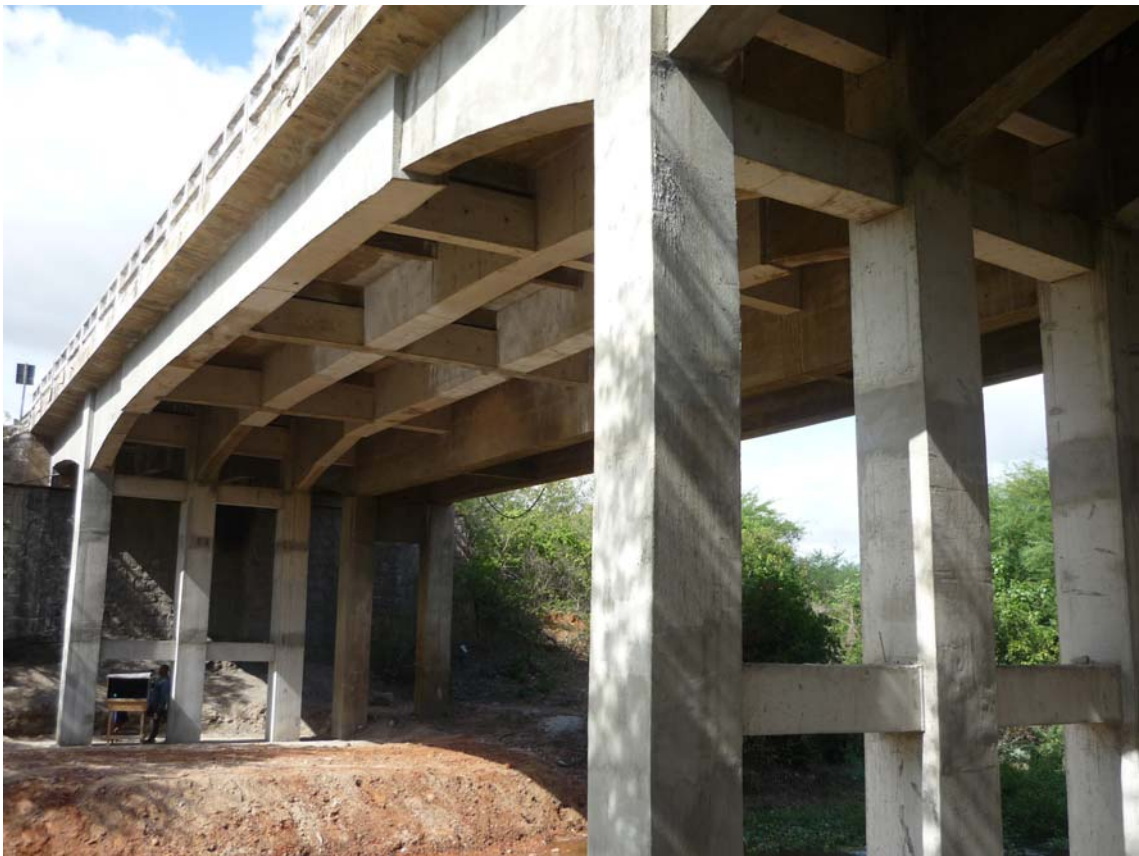
Foto 4 – Outra vista da Ponte reforçada
