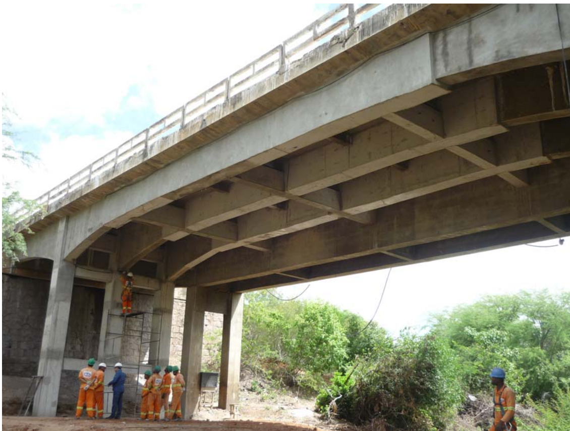
Foto 2 – Vista das Vigas e dos Pilares Juazeiro
