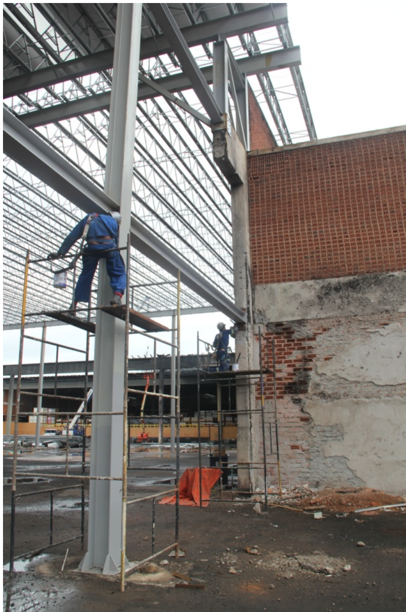
Foto 2 – Reparos sendo feitos nos pilares metálicos e de concreto
