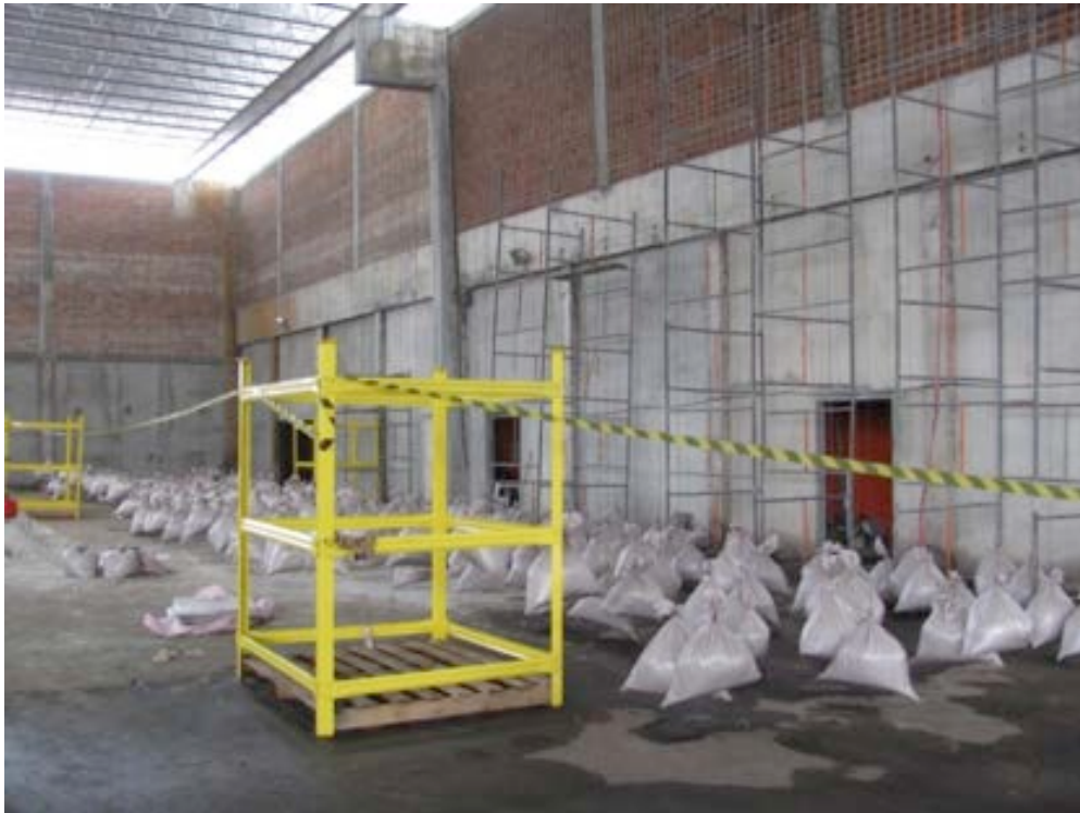
Foto 4 – Carregamento do teste feito com sacos de areia
