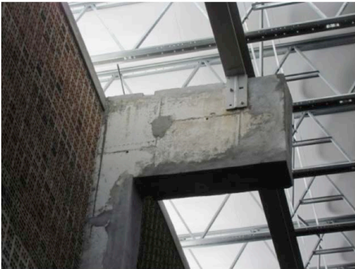
Foto 5 – Detalhe do Consolo da Cobertura
