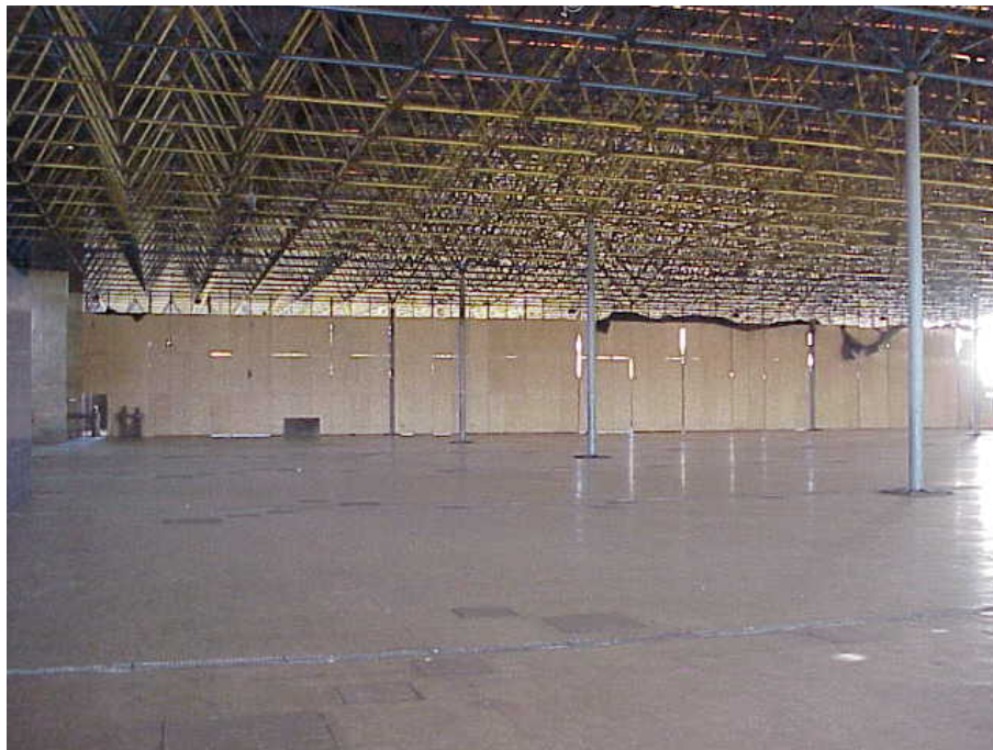
Foto 1 – Vista dos pilares colocados para a execução do serviço
