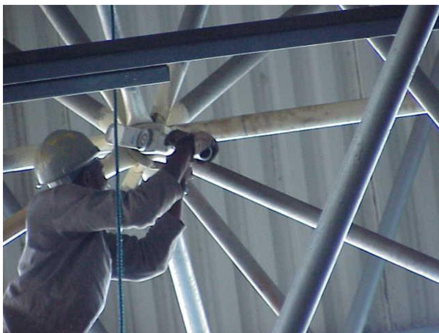
Foto 6 – Aperto dos parafusos com torquímetro
