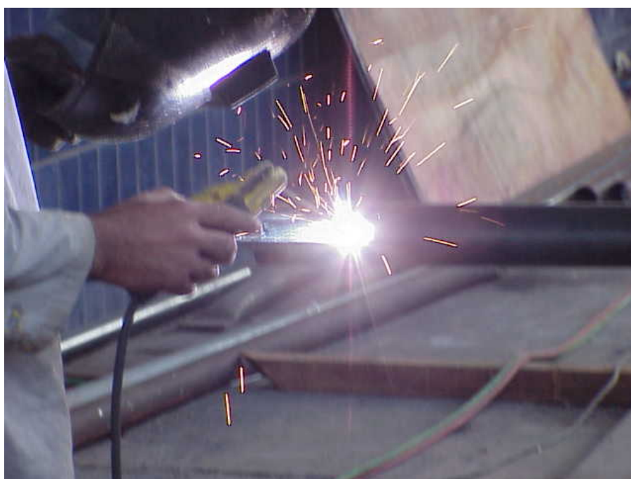
Foto 8 – Soldagem da peça de reforço mostrada na Foto 7 acima
