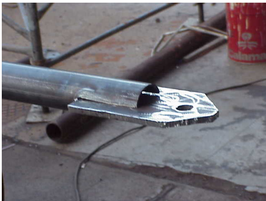
Foto 7 – Fabricação dos tubos de reforço conforme projeto Concremat
