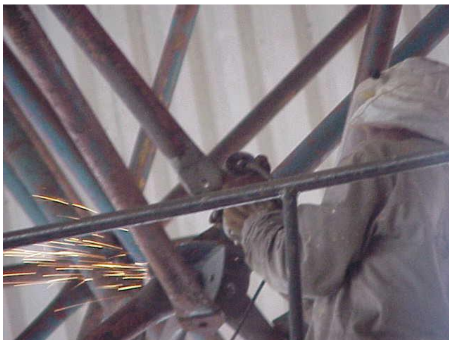
Foto 5 – Substituição dos parafusos e limpeza dos nós
