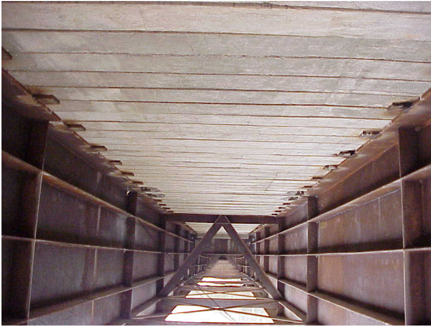
Foto 6 - Detalhe dos conectores laje/viga ao longo de toda a ponte
