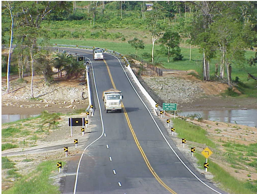
Foto 2 - Vista frontal da ponte durante o teste de carga. Detalhe da passagem de uma caçamba após outra
