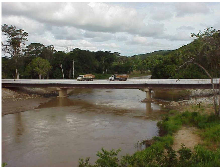
Foto 1 - Vista geral da ponte durante o teste de carga. Detalhe da passagem de duas caçambas
