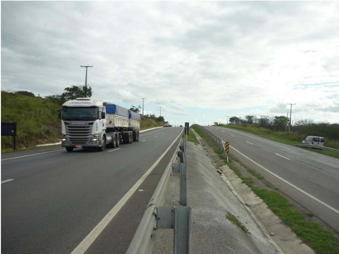
Foto 05 – Vista das pistas sobre o Bueiro Duplo no Km 438, da BR 116 Sul e Carreta sentido Feira de Santana
