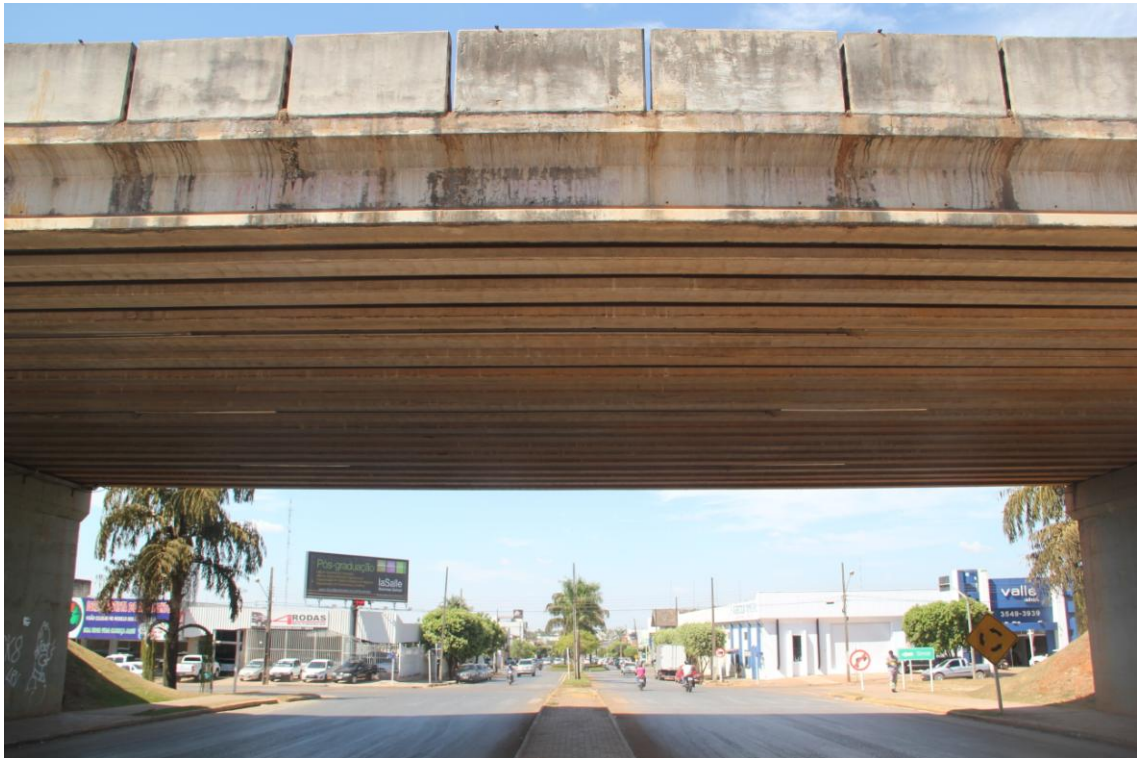
Foto 1 – Vista Inferior do Viaduto
