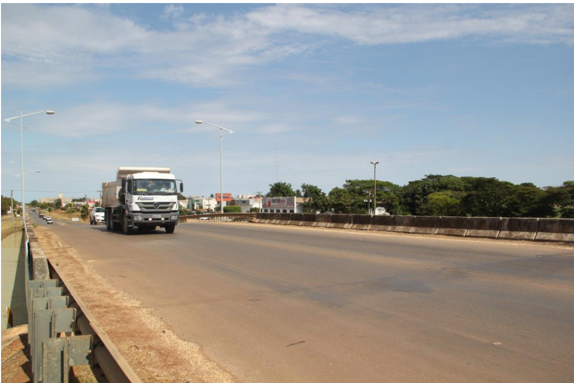
Foto 6 – Caçamba teste passando pelo Viaduto monitorado
