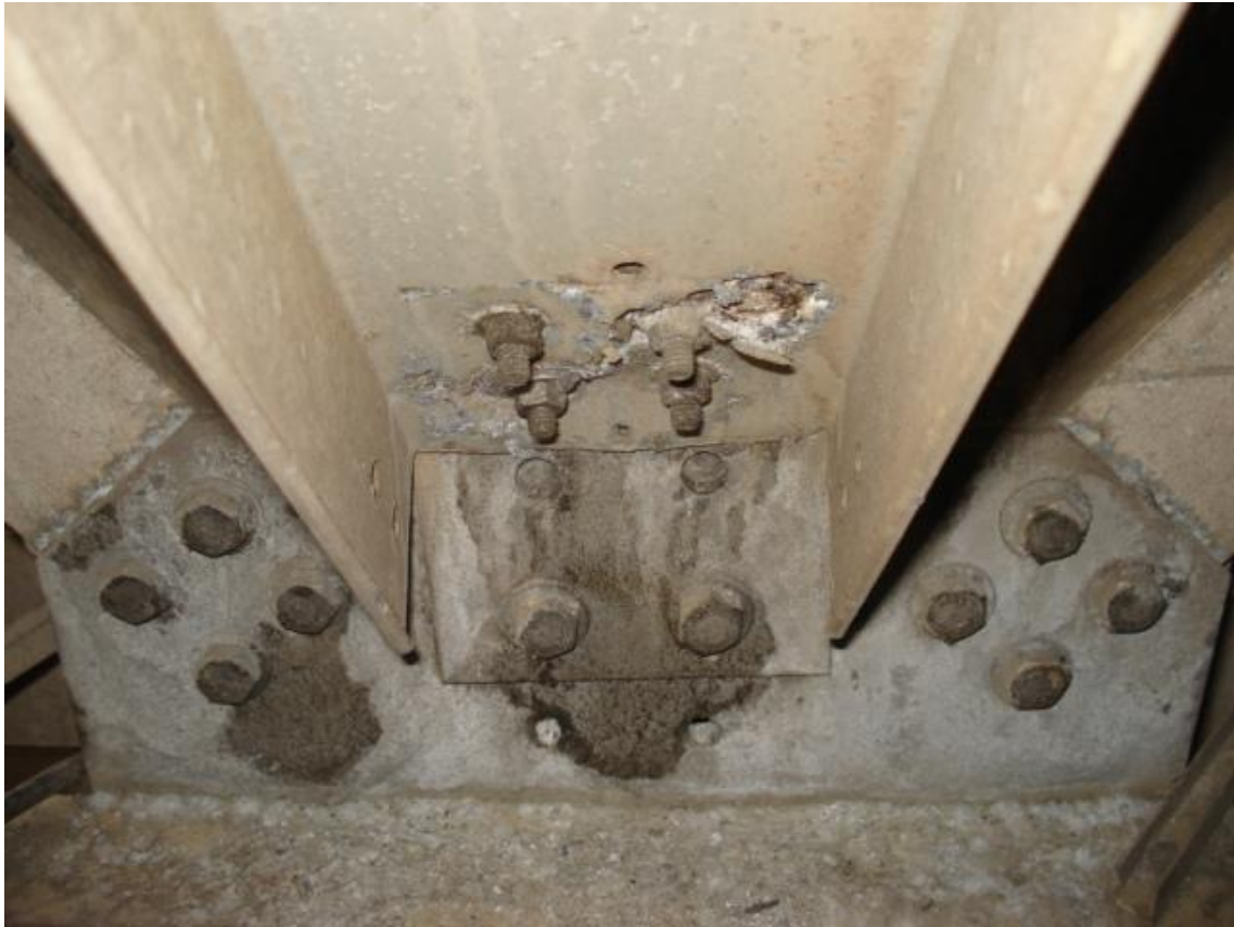
Foto 2 – Parafusos e porcas oxidados
