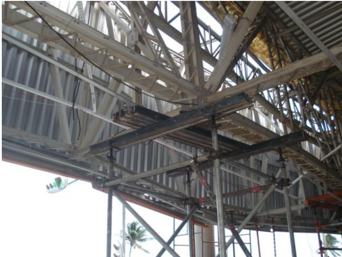
Foto 9 – Outra vista do escoramento
