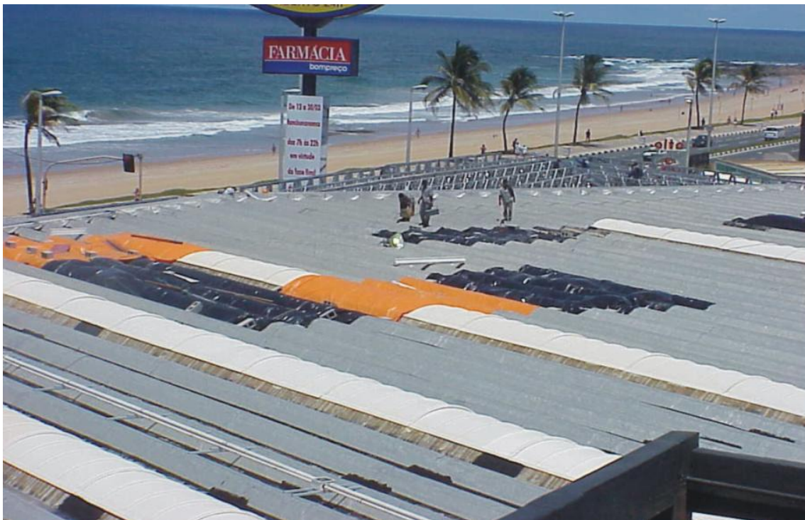
Foto 3 – Vista Geral da cobertura do Bompreço Armção
