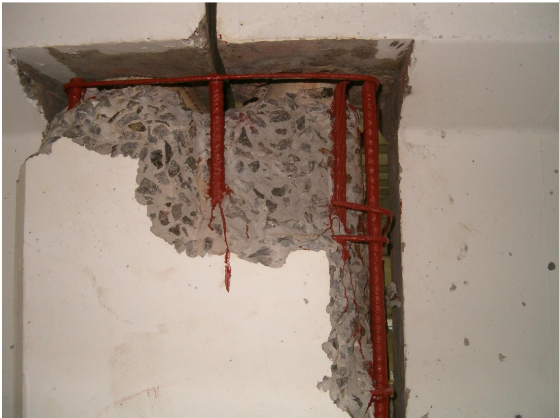
Foto 7 – Detalhe do topo do pilar com as armaduras já tratadas faltando apenas o reparo do cobrimento
