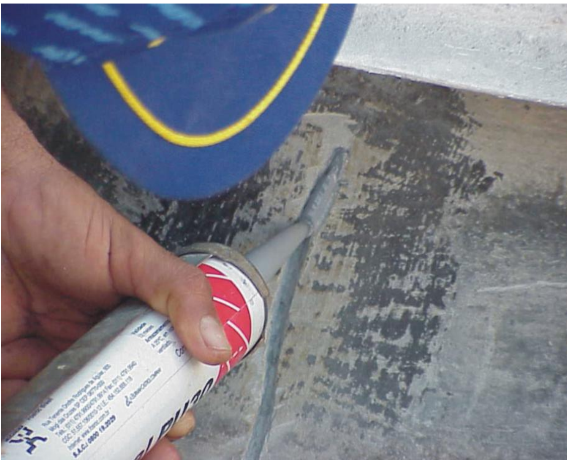
Foto 5 – Reparo estrutura da cobertura
